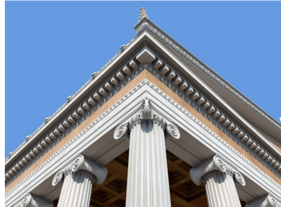
Εικόνα 8 Τρισδιάστατη φωτορεαλιστική απεικόνιση της ΝΑ γωνίας του ναού. Διακρίνεται η διάρθρωση του θριγκού, τμήμα των ξύλινων φατνωμάτων, αλλά κυρίως το πρόβλημα «ένωσης» της σίμης των μακρών πλευρών και της επαέτιας σίμης (Κουρτζέλλης 2012).
